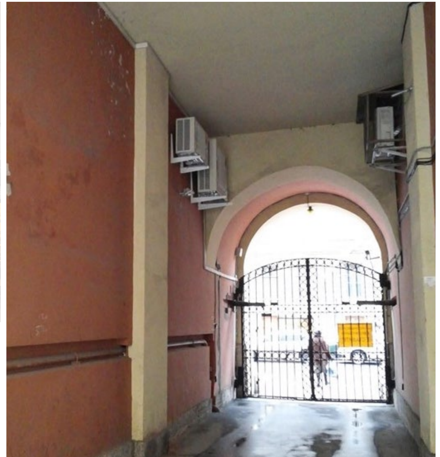
В арке. Кондиционер можно установить в арке на высоте более трех метров. В случае лицевого фасада за скрывающим его размещение — конструктивным элементом арки/декоративным экраном.
